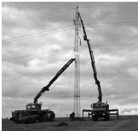
Udskiftning af gittermast.
