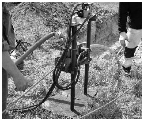
Udstyr til iblæsning af fiberkabel.
