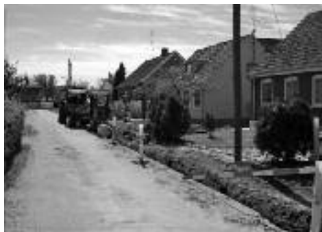
Kabellægning i Ommel.
