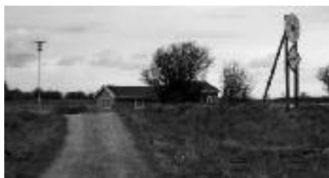
Gadelampe ved det yderste dige på Birkholm. Masten ved siden af er båkerlys til markering af søkablet til Birkholm.
